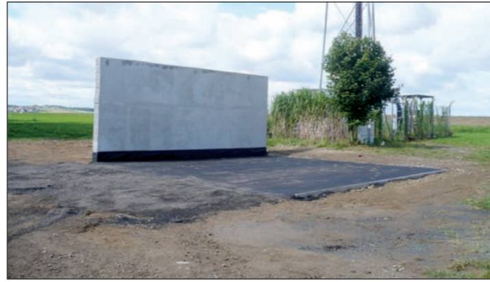
během stavby tréninkové tenisové zdi
