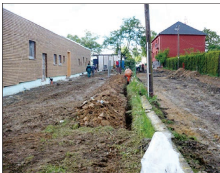
Koncem května začala rekonstrukce ul. Sklopčické
